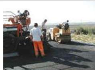
fig. 01 – Operazioni di finitura manto stradale
