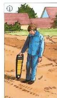
fig. 04 – uso rilevatore sottoservizi
